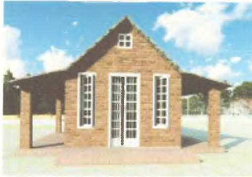
Figura 5: Esquadrias em madeira e vidro da biblioteca
