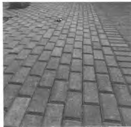
Figura 1: Piso intertravado regular
