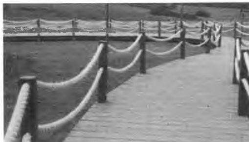
Figura 5: Guarda corpo de madeira e sisal
