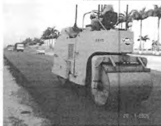
Figura 02: Compactação com rolo tandem de cilindros metálicos.
