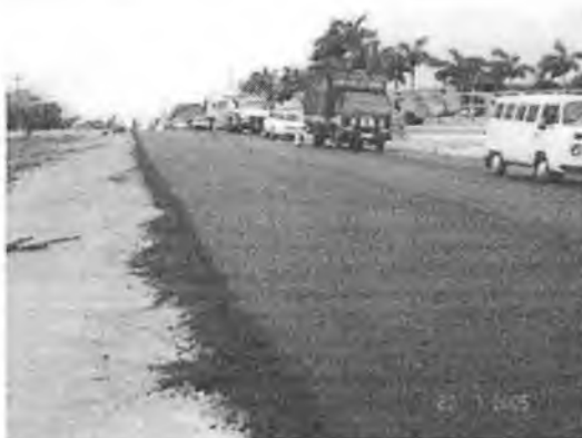
Figura 03: Vista geral da superfície da camada de CPA logo após compactação.
