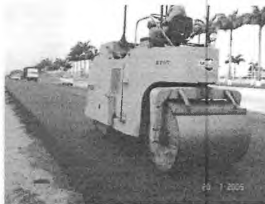
Figura 02: Compactação com rolo tandem de cilindros metálicos.
