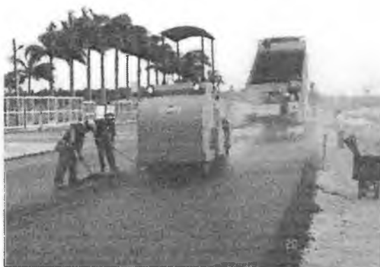
Figura 03: Vista geral da superfície da camada de CPA logo após compactação.
