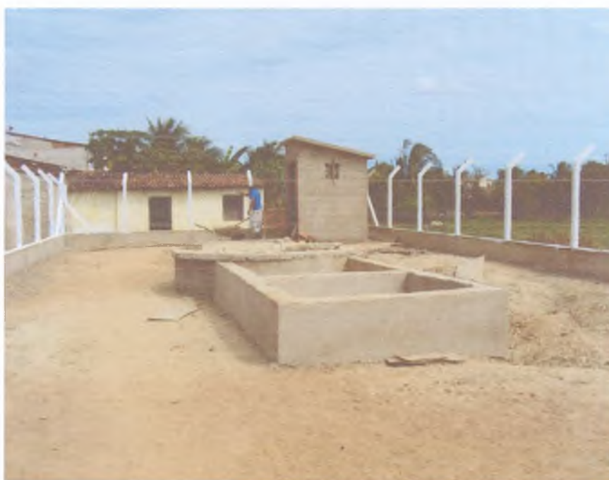
FIG – 03 – EXECUÇÃO DA ESTAÇÃO ELEVATÓRIA 05, FOI FEITO UM ATERRO E BALDRAME DE UMA MÉDIA DE 1,2 M DE ALTURA PARA PROTEGER A MESMA EM PERÍODOS INVERNOSOS.
