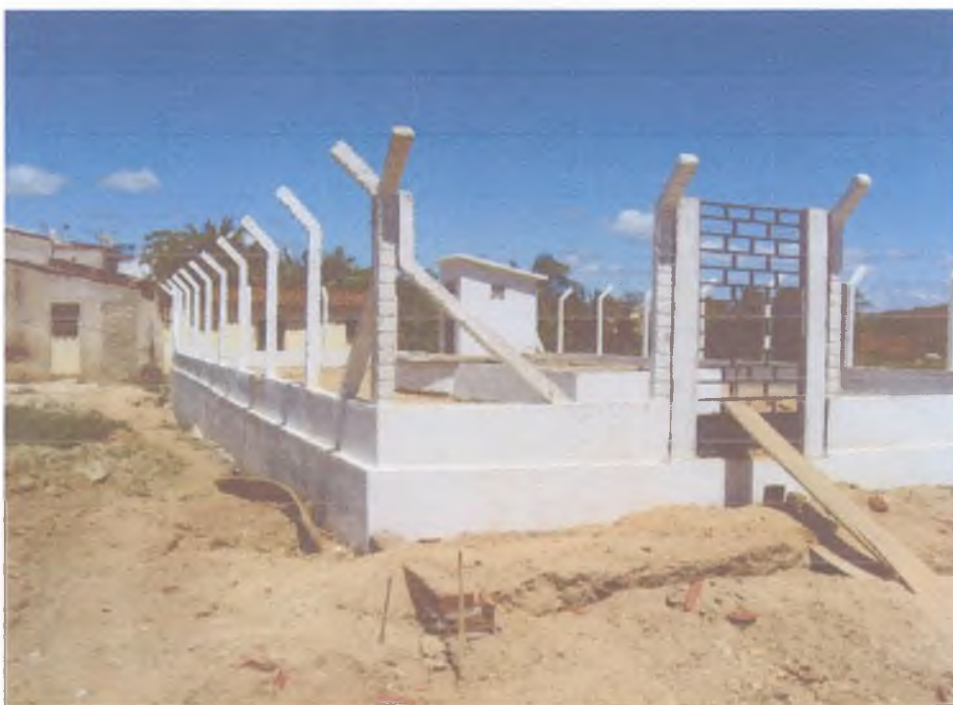
FIG – 07 – CONCLUSÃO DOS SERVIÇOS NA ESTAÇÃO ELEVATÓRIA 05, EXECUÇÃO DE MURETA, EXECUÇÃO DA CASA DE COMANDO E PINTURA.
