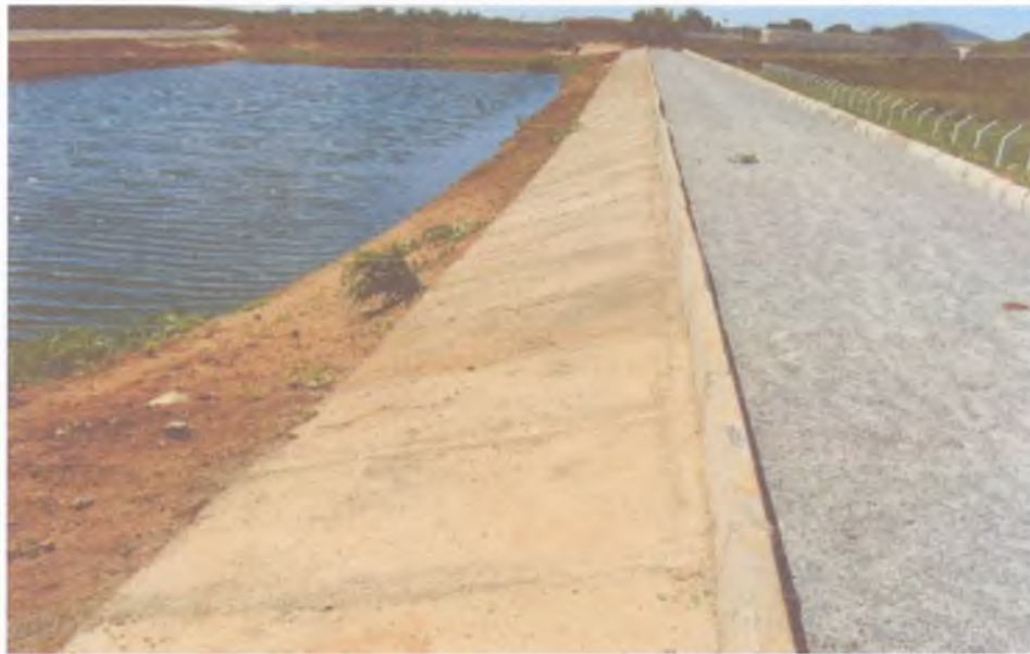
FIG – 02 – SERVIÇOS NAS ESTAÇÕES DE TRATAMENTO, ATERRO PARA REGULARIZAR TALUDES E COROAMENTO COM PÓ DE BRITA, PROTEÇÃO DOS TALUDES E MEIO FIO E ESTACAS EM CONCRETO PRÉ-MOLDADO.
