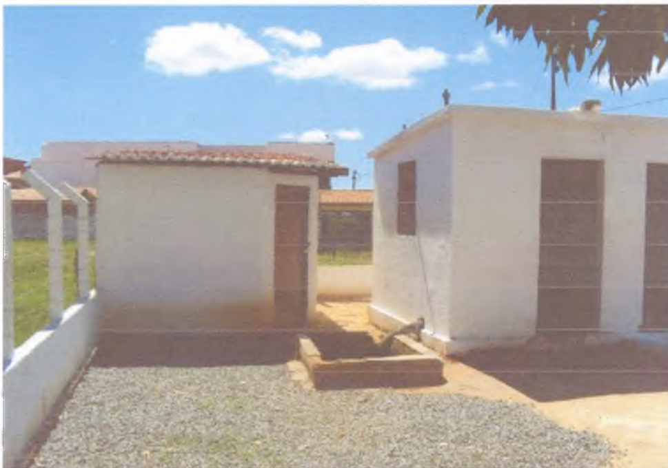
FIG – 05 – SERVIÇOS NA ESTAÇÃO ELEVATÓRIA PRINCIPAL, EXECUÇÃO DE MURETA, LIMPEZA, NOVO ARAME FARPADO, EXECUÇÃO DE DEPÓSITO COBERTO, LASTRO DE BRITA E PINTURA.
