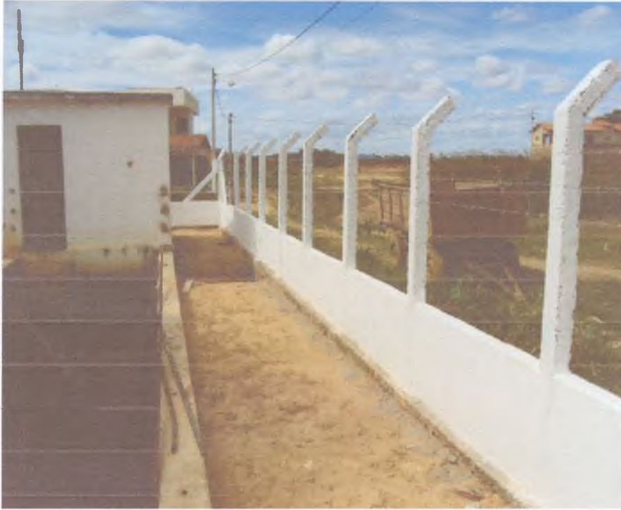
FIG – 16 – REFORMA DA ESTAÇÃO ELEVATÓRIA PRINCIPAL, EXECUÇÃO DA MURETA, LIMPEZA COM CORTES DE ALGUNS ARBUSTOS EXISTENTES E PINTURA A BASE DE CAL.
