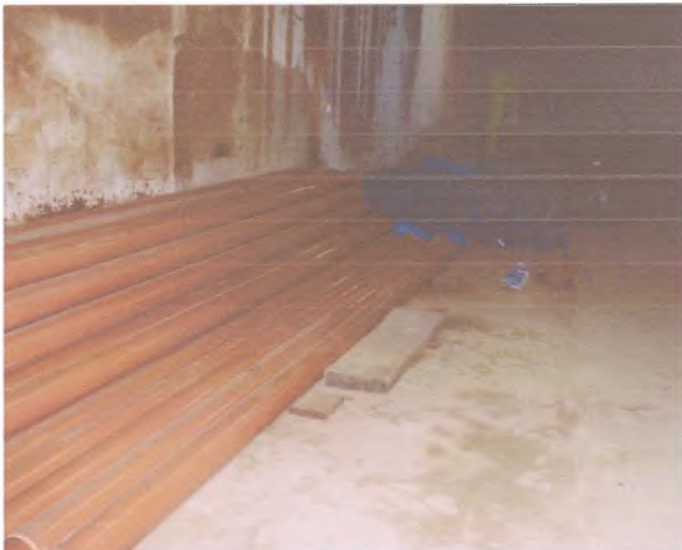
FIG – 21 – BARRACÃO DA OBRA, ARMAZENAMENTO DA TUBULAÇÃO.
