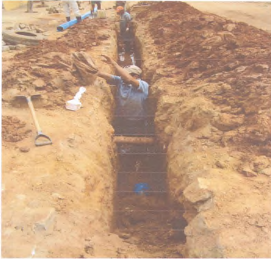
FIG – 14 – EXECUÇÃO DO RECALQUE DA ESTAÇÃO ELEVATÓRIA 04 A ESTAÇÃO ELEVATÓRIA PRINCIPAL.
