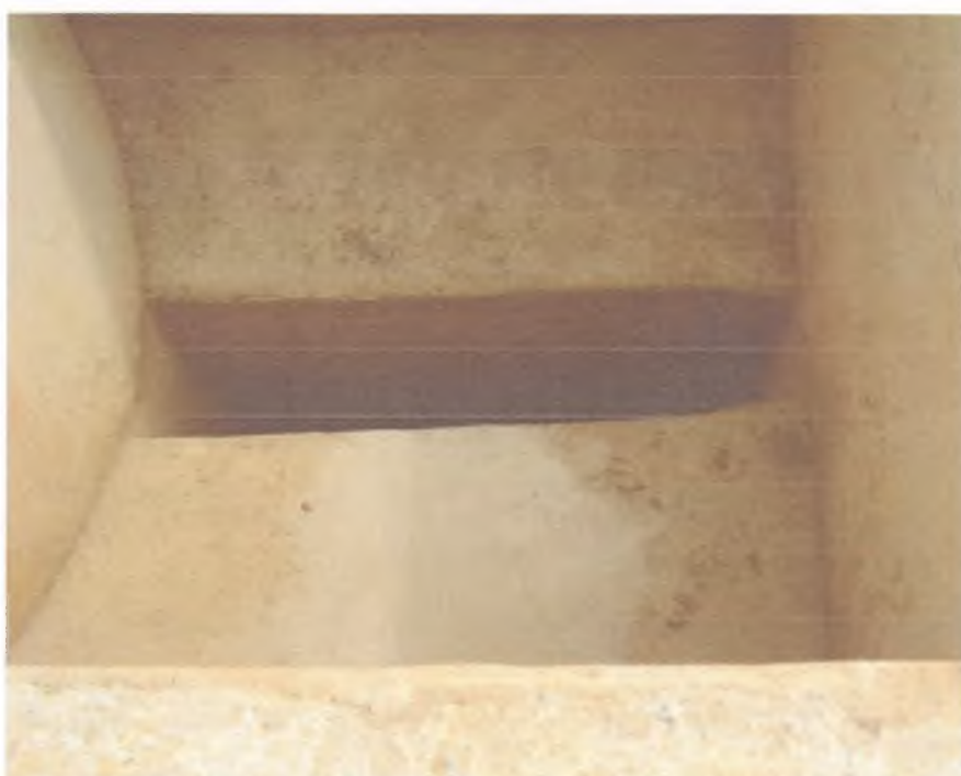
FIG - 05 - CALHA DA ESTAÇÃO ELEVATÓRIA 05
