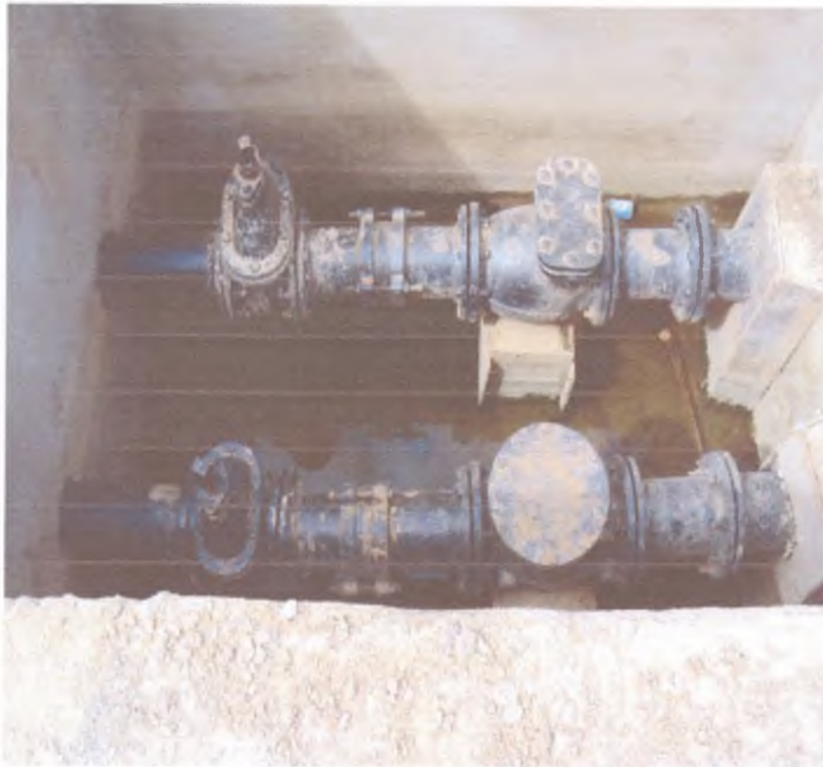
FIG – 08 – REGISTRO DA ESTAÇÃO ELEVATÓRIA 04, ESTÁ EXECUTADO EM CONFORMIDADE COM O PROJETO.
