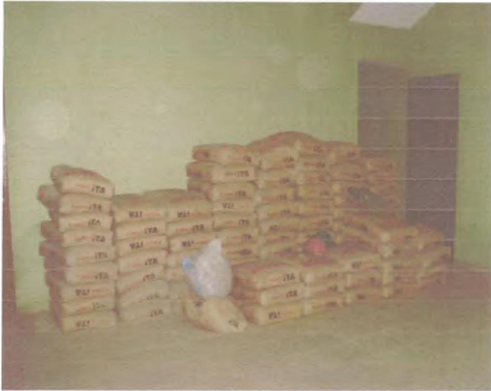
FIG – 22 – BARRACÃO DA OBRA, ARMAZENAMENTO DE CIMENTO.
