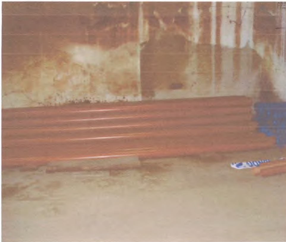
FIG – 20 – BARRACÃO DA OBRA, ARMAZENAMENTO DA TUBULAÇÃO.
