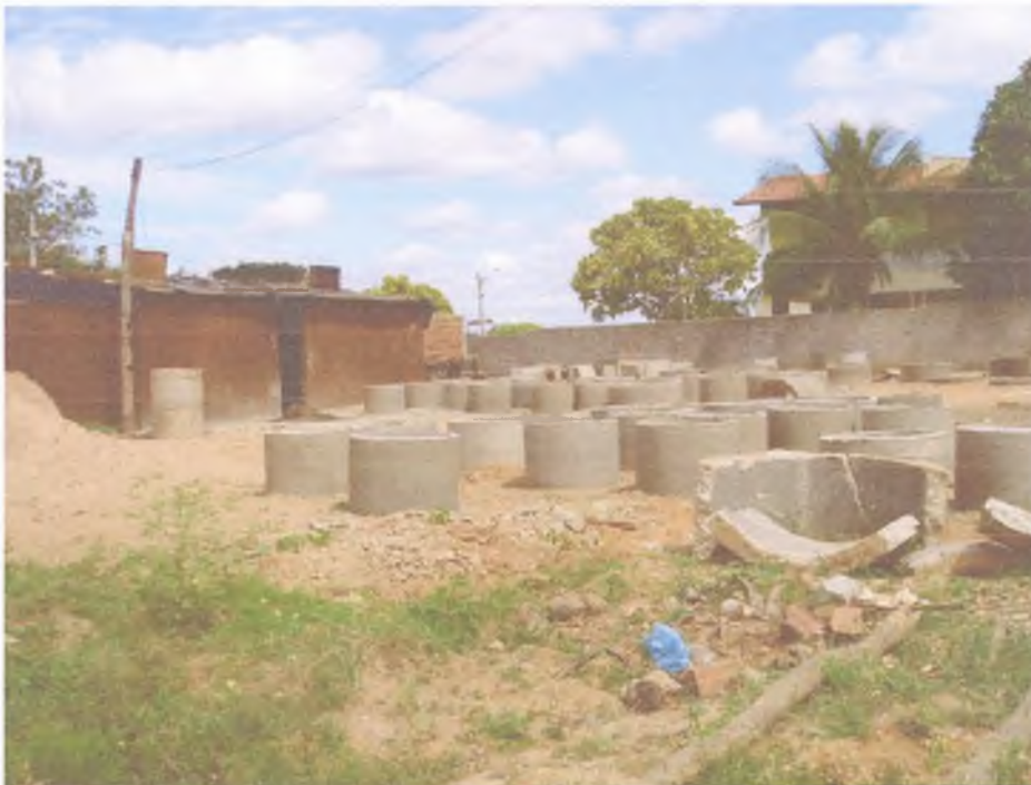
FIG – 19 – BARRACÃO DA OBRA E EXECUÇÃO DAS MANILHAS DOS PV'S
