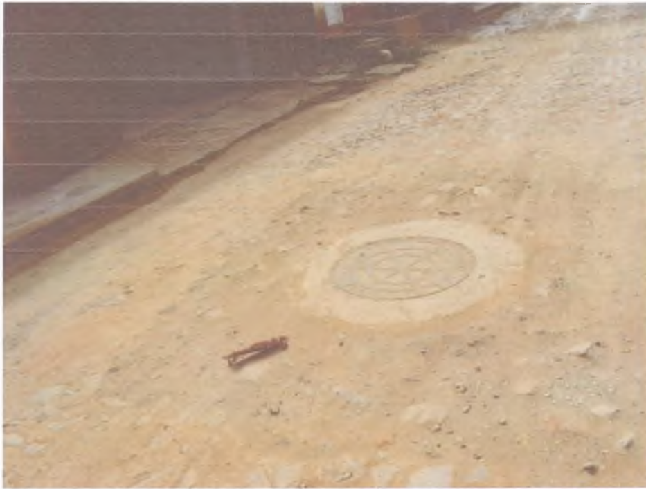
FIG – 18 –CONCLUSÃO DA EXECUÇÃO DA REDE, REALIZANDO RETOQUES NOS PV'S E ARREMATES ENTRE OS PV'S E O CALÇAMENTO.
