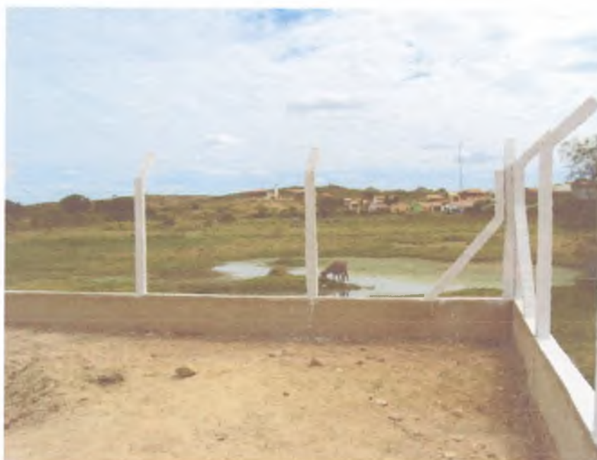
FIG - 04 - EXECUÇÃO DA ESTAÇÃO ELEVATÓRIA 05, FOI FEITO UM ATERRO E BALDRAME DE UMA MÉDIA DE 1,2 M DE ALTURA PARA PROTEGER A MESMA EM PERÍODOS INVERNOSOS.
