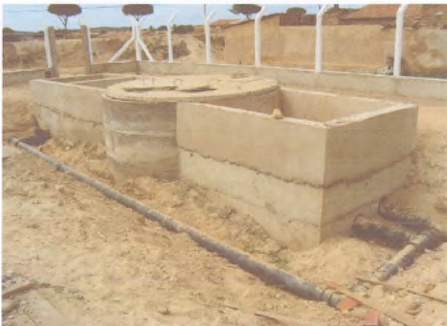
FIG – 07 – CONSTRUÇÃO DA ESTAÇÃO ELEVATÓRIA 04, ESTÁ EXECUTADO EM CONFORMIDADE COM O PROJETO.
