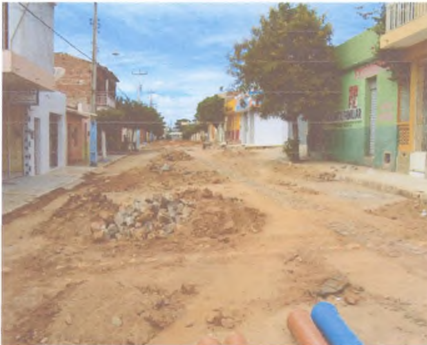
FIG – 13 – EXECUÇÃO DO RECALQUE DA ESTAÇÃO ELEVATÓRIA 04 A ESTAÇÃO ELEVATÓRIA PRINCIPAL.
