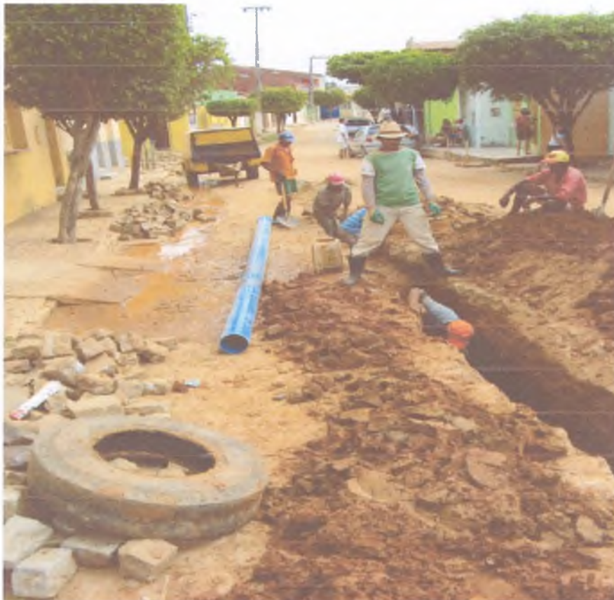
FIG – 14 – EXECUÇÃO DO RECALQUE DA ESTAÇÃO ELEVATÓRIA 04 A ESTAÇÃO ELEVATÓRIA PRINCIPAL.
