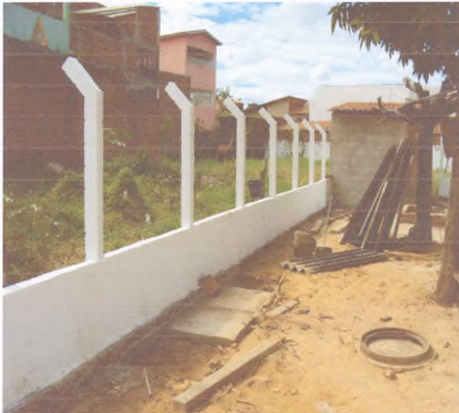
FIG – 17 – REFORMA DA ESTAÇÃO ELEVATÓRIA PRINCIPAL, EXECUÇÃO DA MURETA, LIMPEZA COM CORTES DE ALGUNS ARBUSTOS EXISTENTES E PINTURA A BASE DE CAL.
