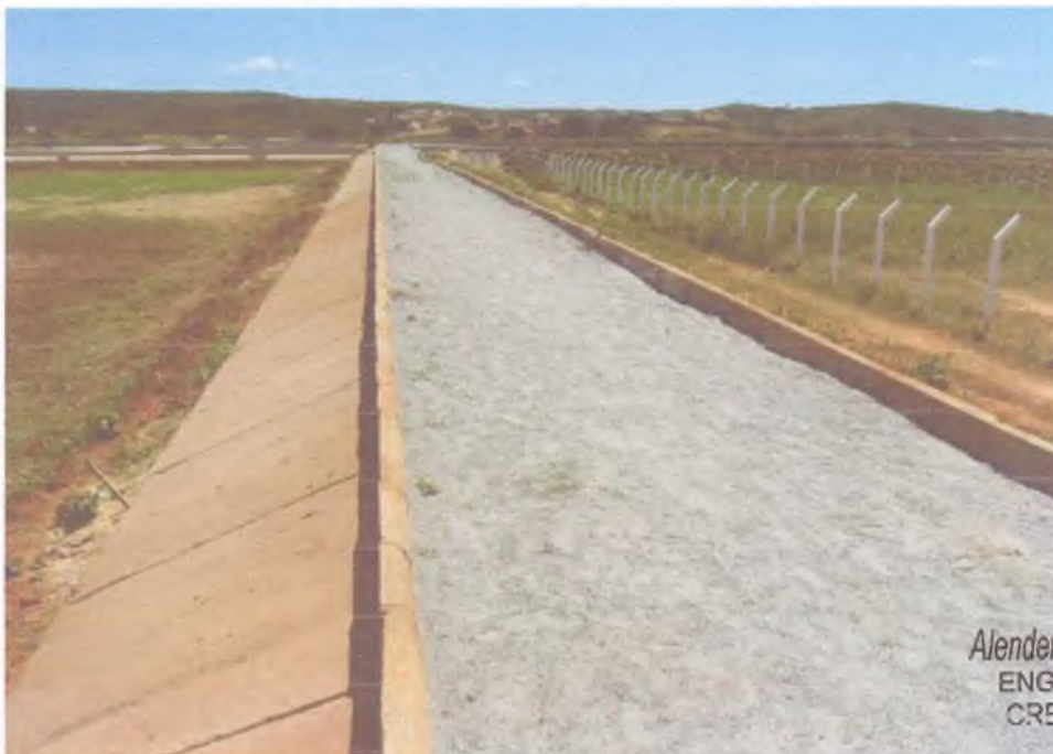
FIG 01 – SERVIÇOS NAS ESTAÇÕES DE TRATAMENTO, ATERRO PARA REGULARIZAR TALUDES E COROAMENTO COM LASTRO DE PÓ DE BRITA, PROTEÇÃO DOS TALUDES E MEIO FIO E ESTACAS EM CONCRETO PRÉ-MOLDADO.
