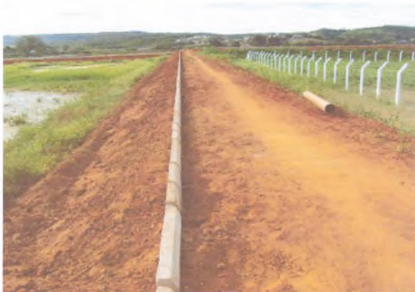
FIG 01 – SERVIÇOS NAS ESTAÇÕES DE TRATAMENTO, ATERRO PARA REGULARIZAR TALUDES E COROAMENTO, MEIO FIO E ESTACAS EM CONCRETO PRÉ-MOLDADO.
