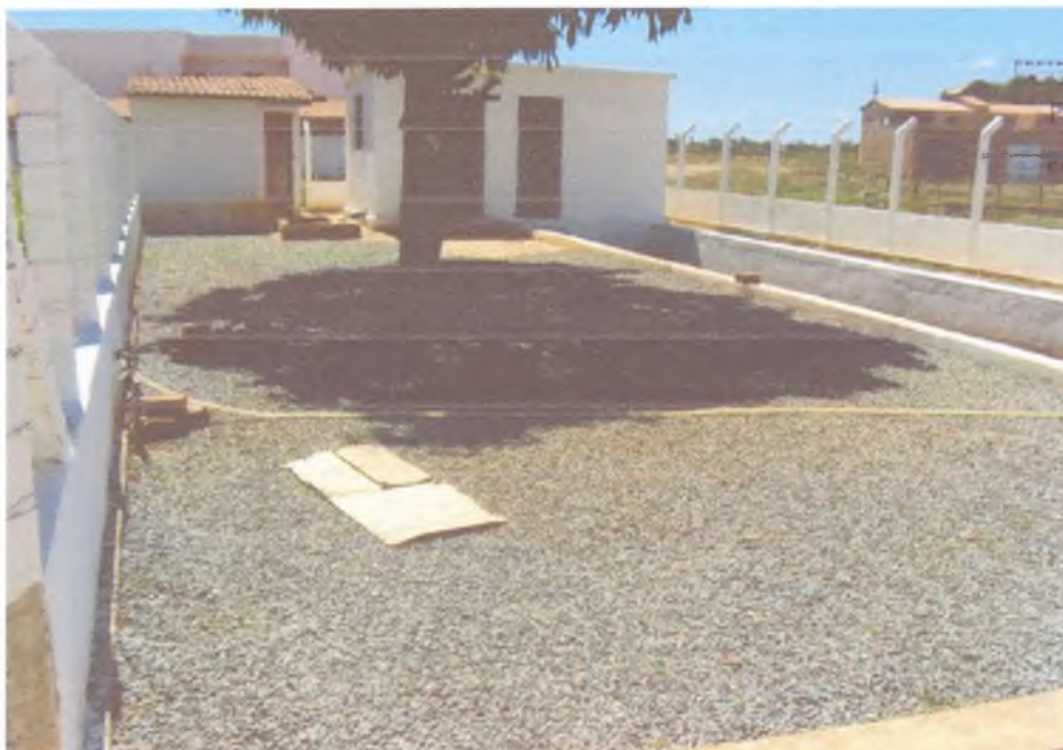
FIG – 06 – SERVIÇOS NA ESTAÇÃO ELEVATÓRIA PRINCIPAL, EXECUÇÃO DE MURETA, LIMPEZA, NOVO ARAME FARPADO, EXECUÇÃO DE DEPÓSITO COBERTO, LASTRO DE BRITA E PINTURA.
