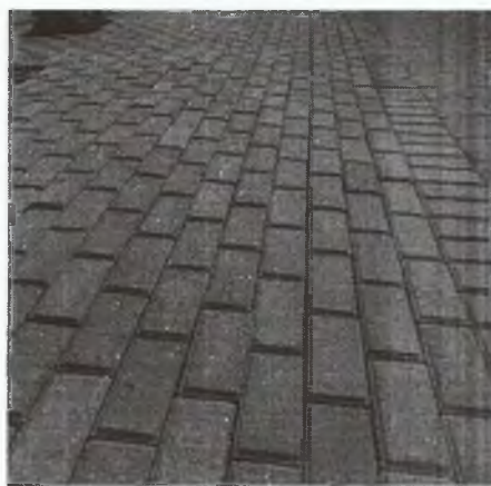
Figura 1: Piso intertravado regular
