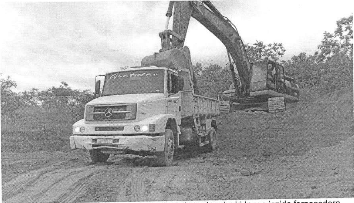
Imagem 9 – Nossos equipamentos coletando areia adquirida em jazida fornecedora
