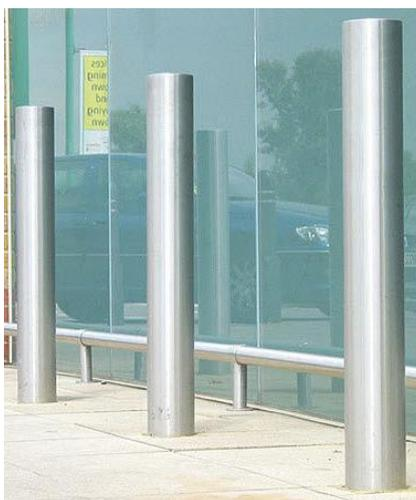
**Figura 5:** Balizador de proteção em aço inox
