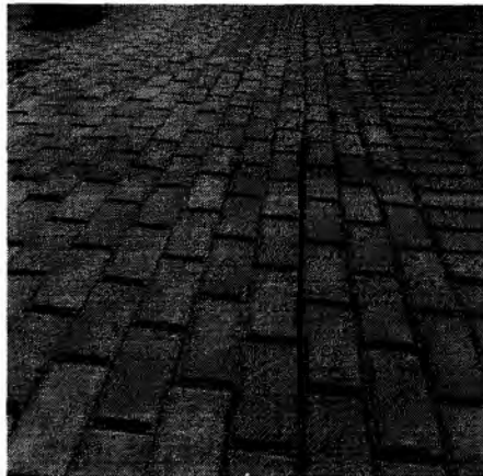
Figura 2: Passeio em piso intertravado retangular
