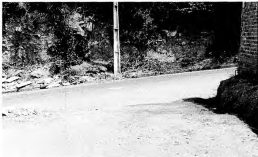
Foto 31 - Início da Rua Nossa Senhora da Penha (452740-9200088)
