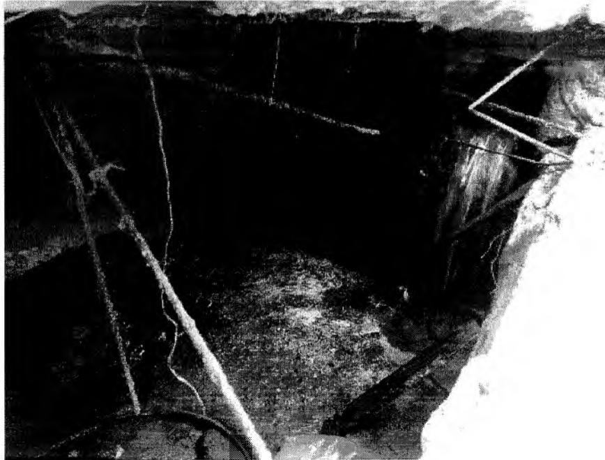
FIGURA 12. PC-02 – BY-PASS DA ETE VITÓRIA NOSSA - DESATIVADA.
