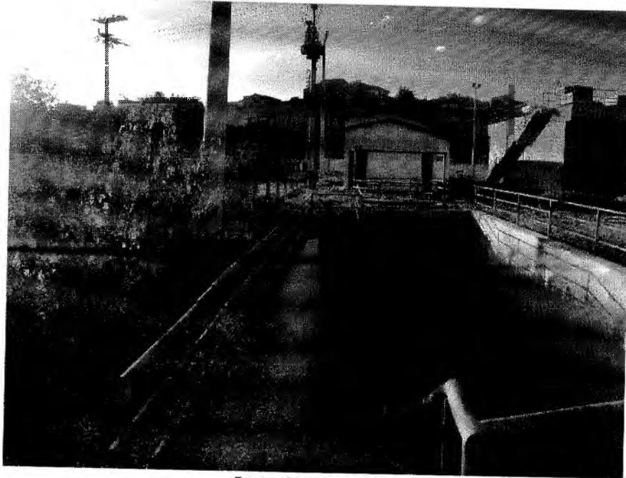
FIGURA 43. VISTA GERAL DO TRATAMENTO PRELIMINAR.
