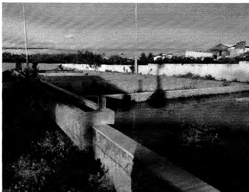
FIGURA 60. LEITOS DE SECAGEM.
