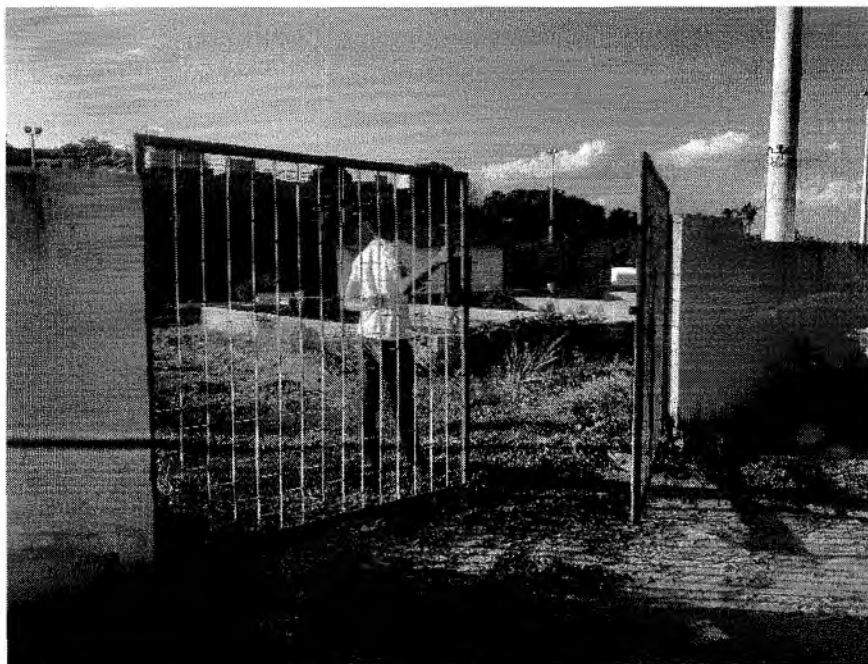
FIGURA 42. VISTA GERAL DO ACESSO A ETE.
