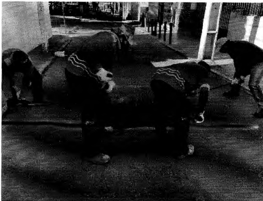
FIGURA 23. DESOBSTRUÇÃO DE REDE COLETORA.
