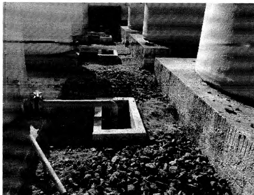
FIGURA 33. RETIRADA DOS MEIOS SUPORTES (BRITAS) DOS FILTROS BIOLÓGICOS.
