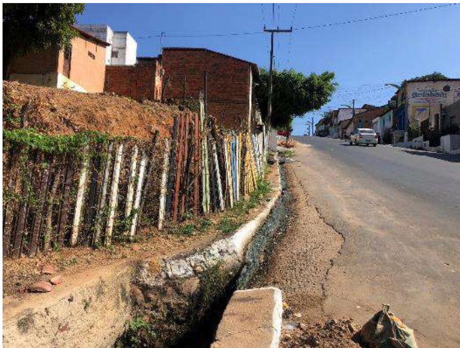
FIGURA 13. PC-03 - LANÇAMENTO DE ESGOTO A CÉU ABERTO.
