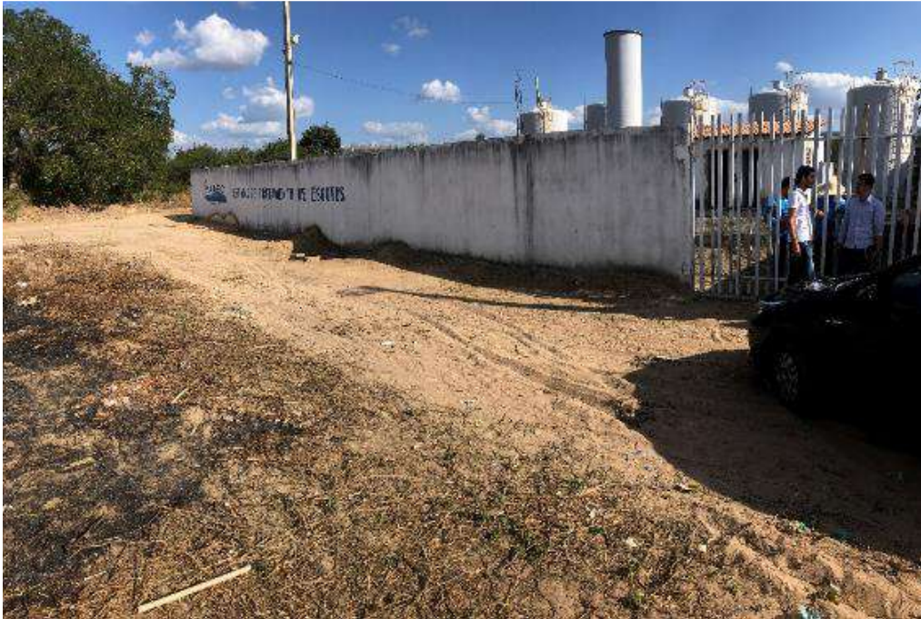
FIGURA 26. VISTA GERAL DO ACESSO A ÁREA DA ETE.
