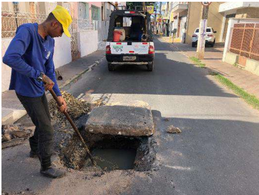
FIGURA 19. PC-07 – DESOBSTRUÇÃO DE REDE COLETORA.
