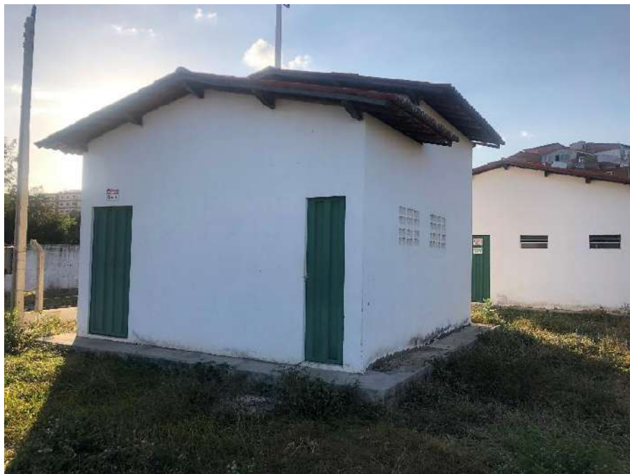
FIGURA 54. VISTA GERAL DA CASA DO GERADOR.
