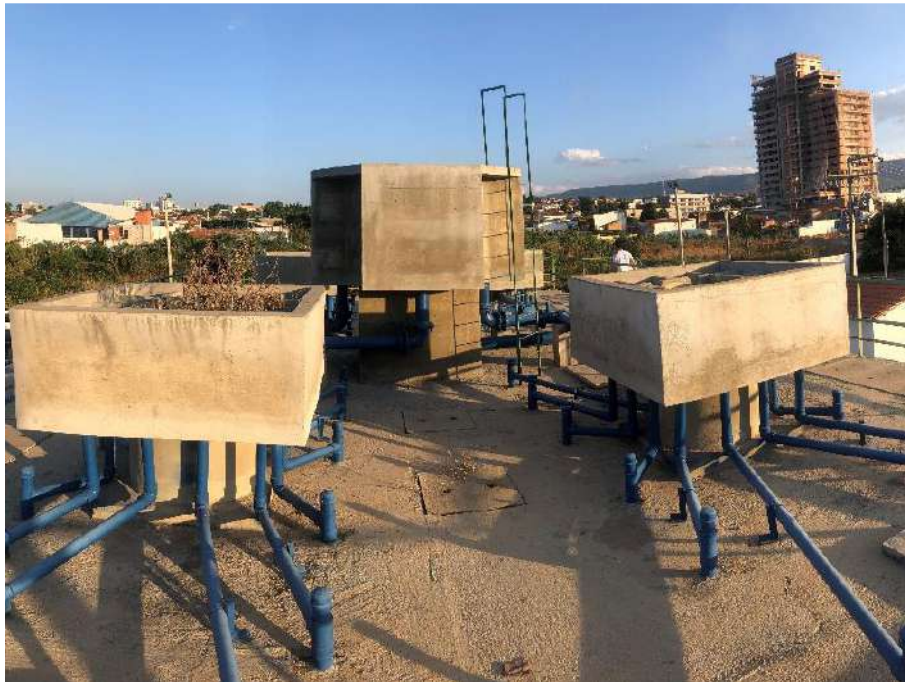
FIGURA 47. VISTA GERAL DA PARTE SUPERIOR DO UASB.
