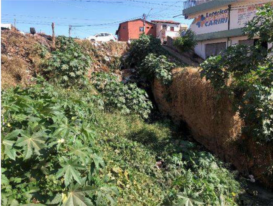
FIGURA 14. PC-04 - LANÇAMENTO DE ESGOTO A CÉU ABERTO.
