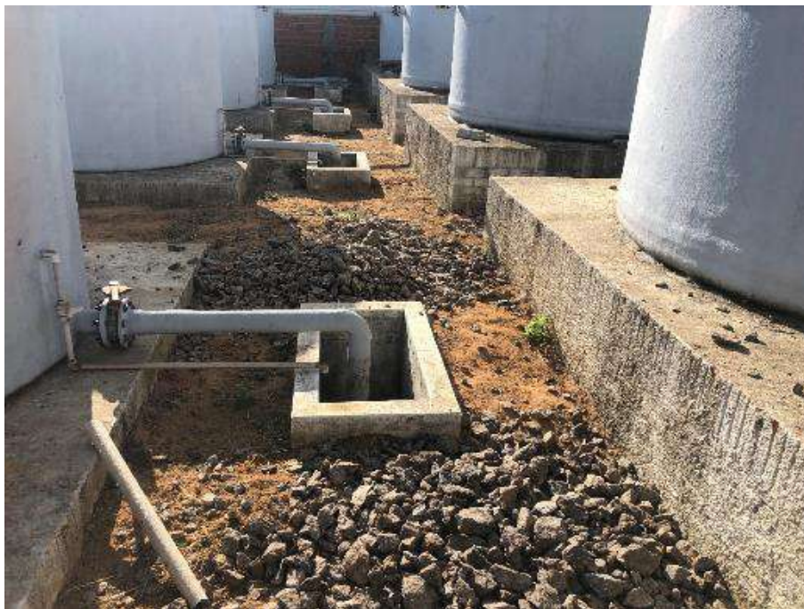
FIGURA 33. RETIRADA DOS MEIOS SUPORTES (BRITAS) DOS FILTROS BIOLÓGICOS.
