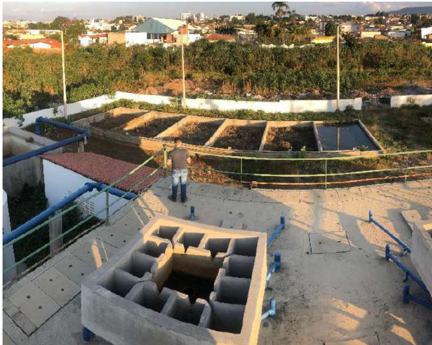
FIGURA 59. VISTA GERAL DOS LEITOS DE SECAGEM.
