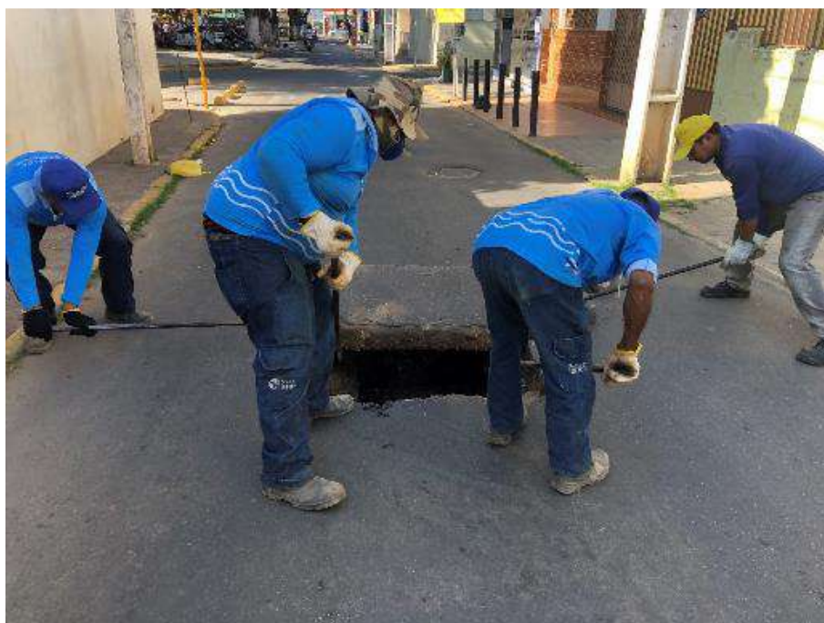
FIGURA 23. DESOBSTRUÇÃO DE REDE COLETORA.
