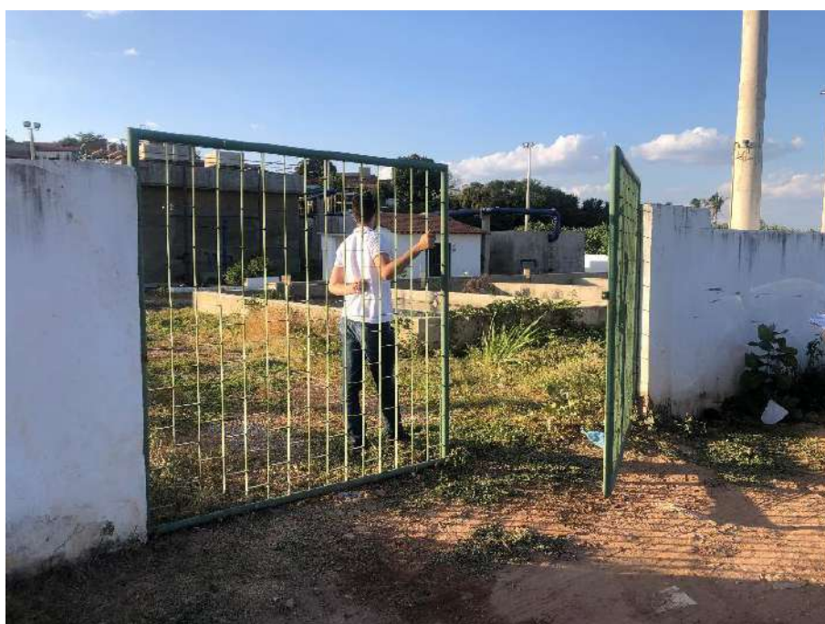
FIGURA 42. VISTA GERAL DO ACESSO A ETE.
