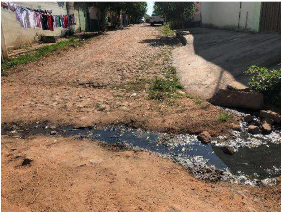
FIGURA 15. PC-05 - LANÇAMENTO DE ESGOTO A CÉU ABERTO.
