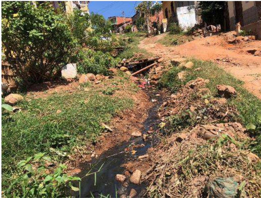
FIGURA 20. PC-08 - LANÇAMENTO DE ESGOTO A CÉU ABERTO.
