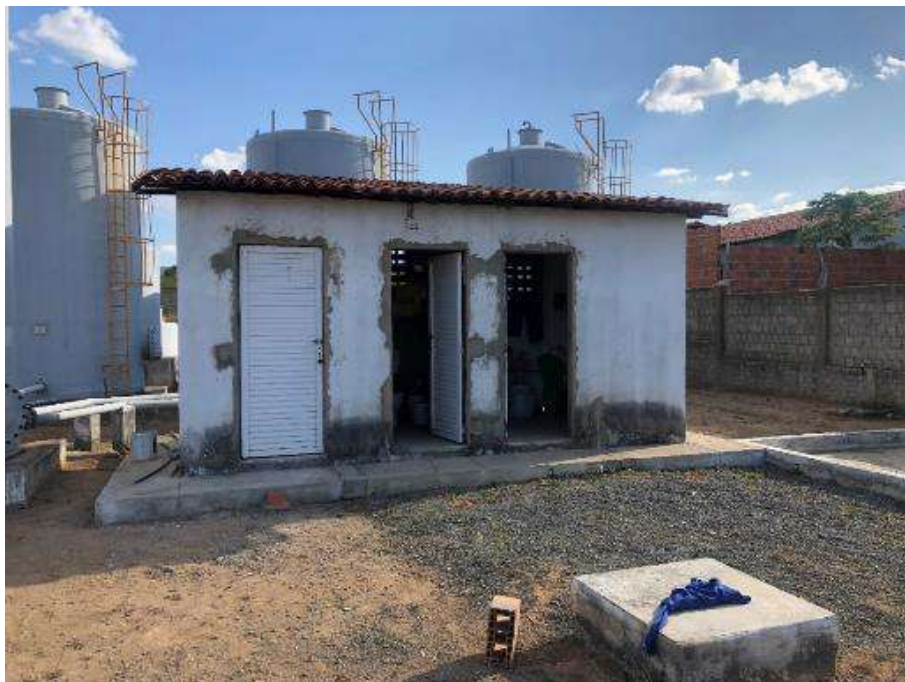
FIGURA 37. CASA DE ALMOXARIFADO, BANHEIRO, PAINÉIS E QUÍMICOS.
