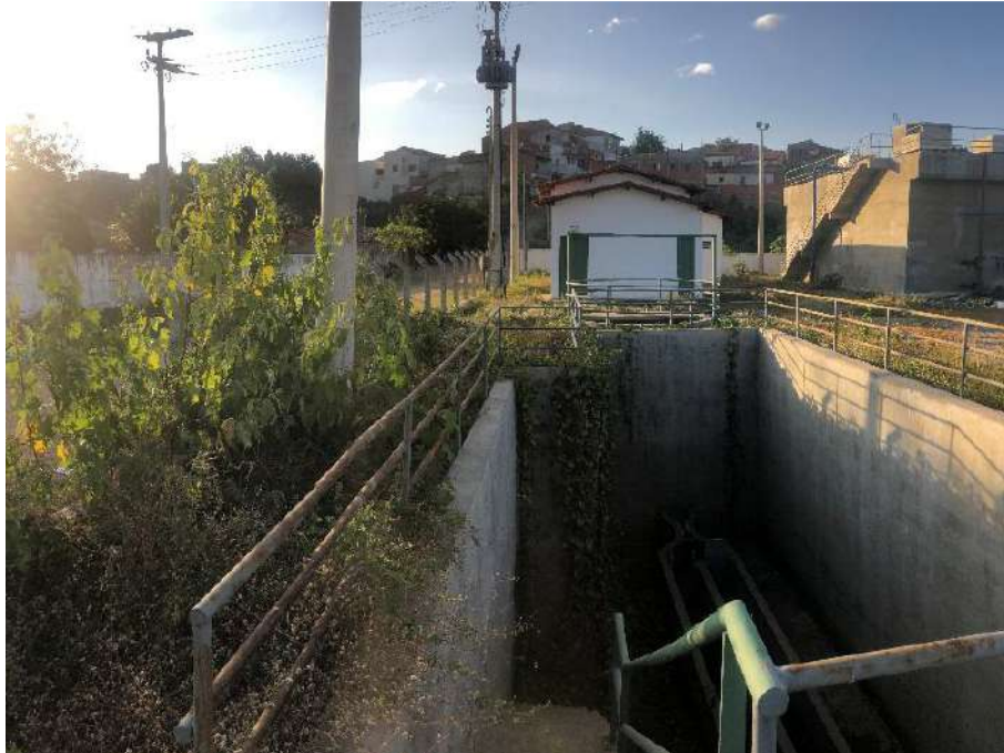
FIGURA 43. VISTA GERAL DO TRATAMENTO PRELIMINAR.
