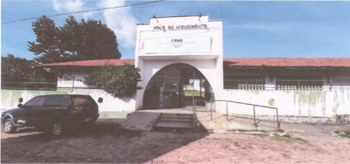
Foto 01 – Fachada do CRAS
