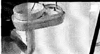
Tubulação totalmente embutida
