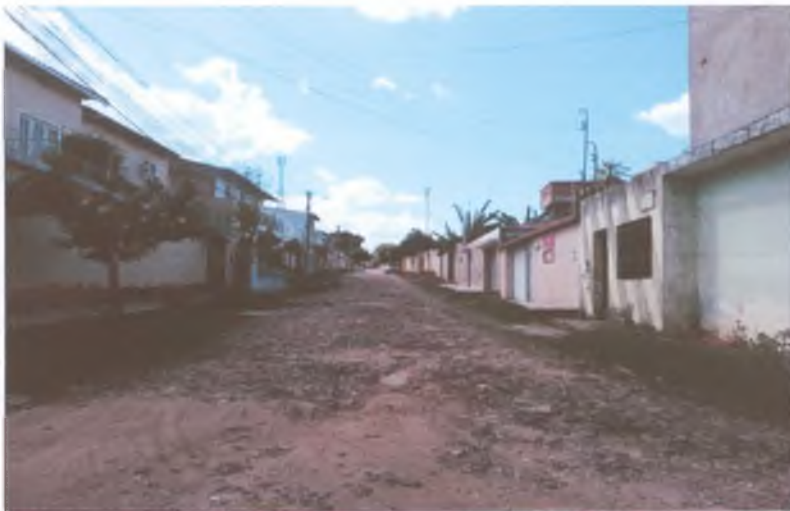
Foto 06 - Final da 3 - RUA DR. EMERSON BARBOSA
