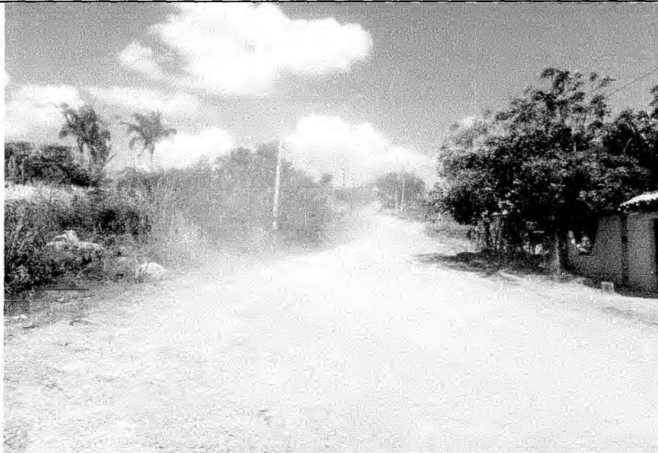
Foto 07 - Início da Estrada de Acesso ao Sítio Fábricas e Valentim
