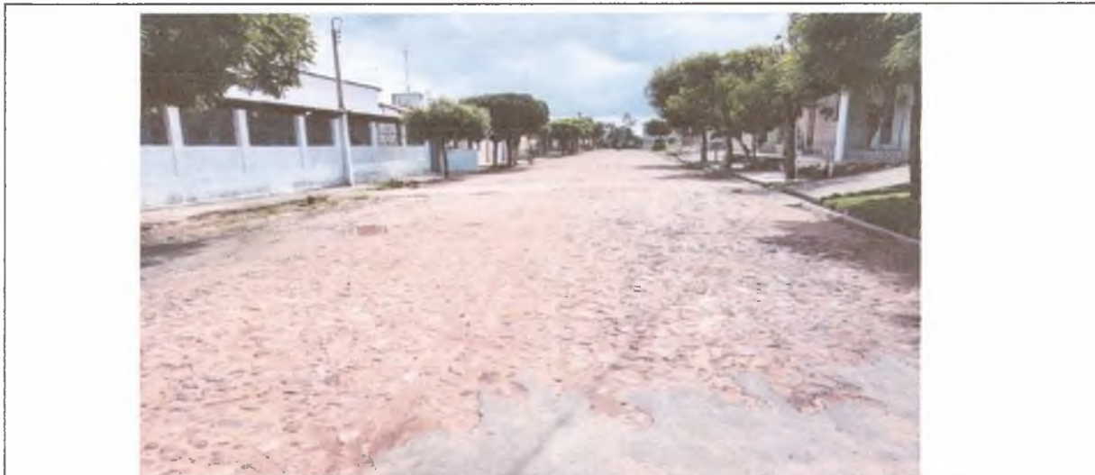
Foto 01 - Início da RUA SÃO FRANCISCO MONTE ALVERNE - TRECHO 01 (Coordenadas: 442169,15 E 9212500,09 S)
