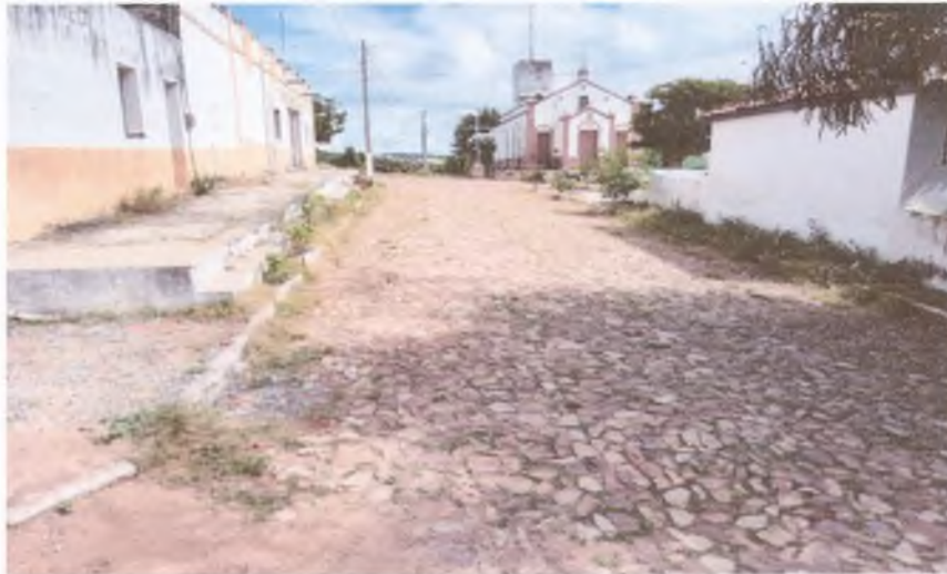
Foto 03 - Início da RUA SAO FRANCISCO MONTE ALVERNE - TRECHO 02 (Coordenadas: 442232,97 E 921258,73 S)
