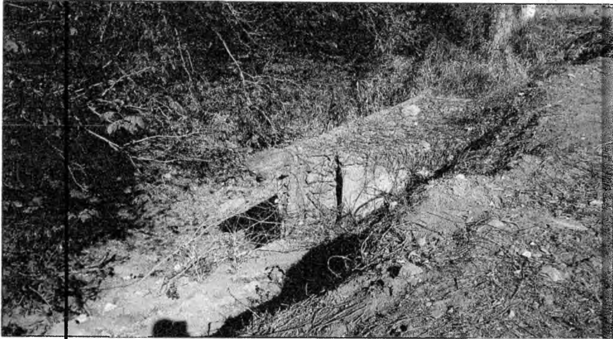
Foto 07 - Boca de bueiro das manilhas de concreto
