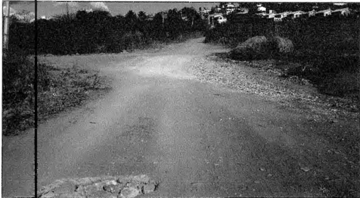
Foto 17 - Trecho final (E 54+0,0 - E 55+0,0)
