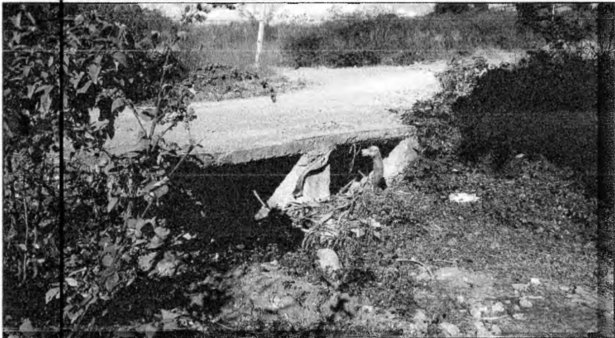
Foto 16 - Bueiro existente (E 53+0,0)
