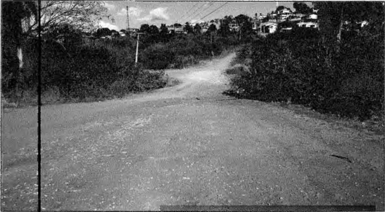
Foto 15 - Trecho final (E 51+0,0 - E 55+0,0)
