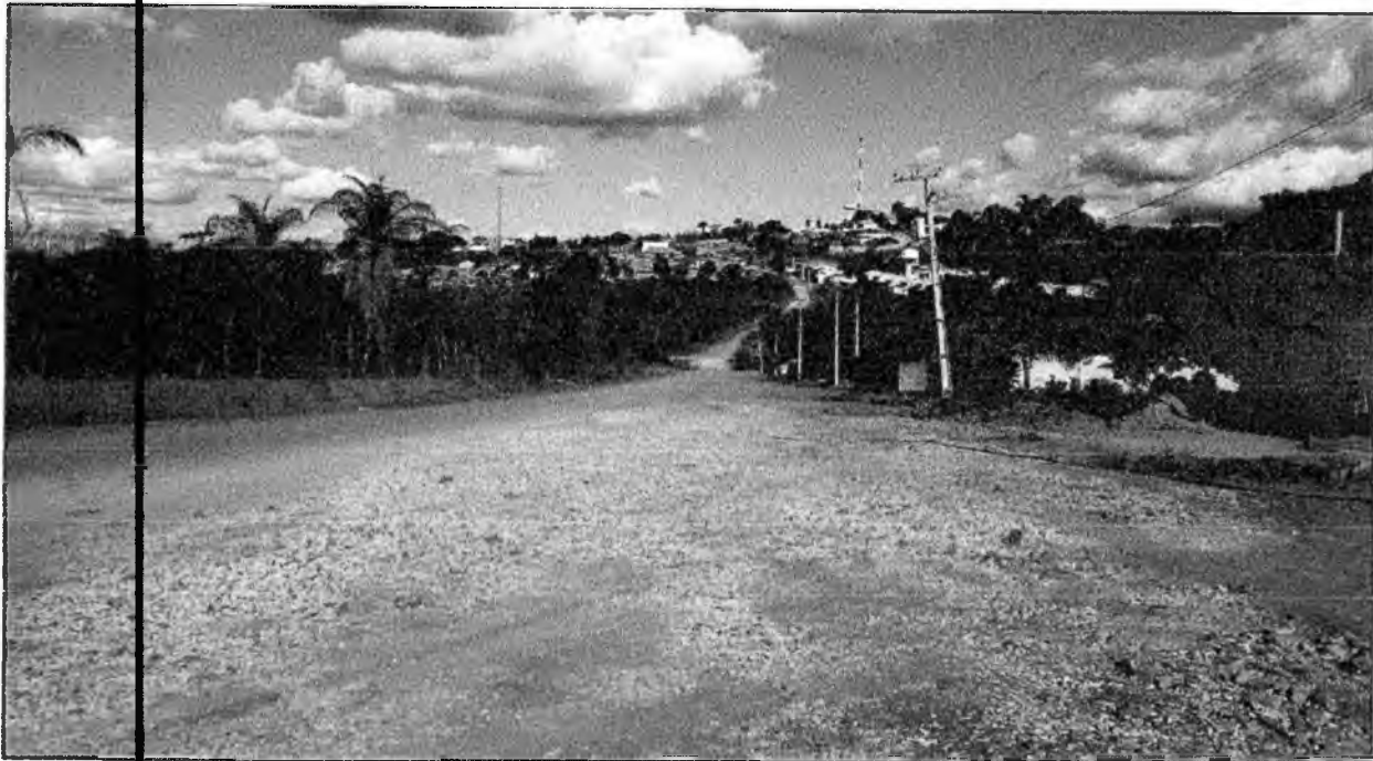
Foto 14 - Trecho intermediário e final (E 40+0,0 - E 55+0,0)
