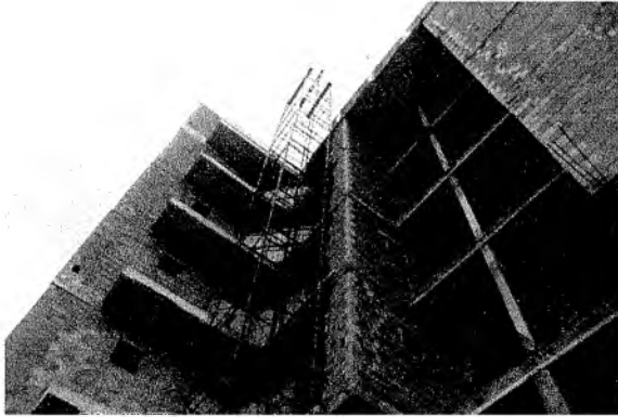
Figura 14 - Acompanhamento da obra do Hospital Regional Norte – Sobral – com área total de 55.000,00m 2
