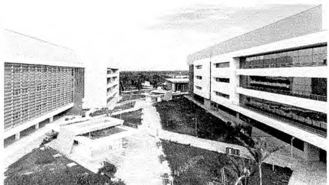
Figura 21 - Acompanhamento da obra do Campus da Fiocruz Ceará 30.000,00m 2 (área edificada) – Obra finalizada
