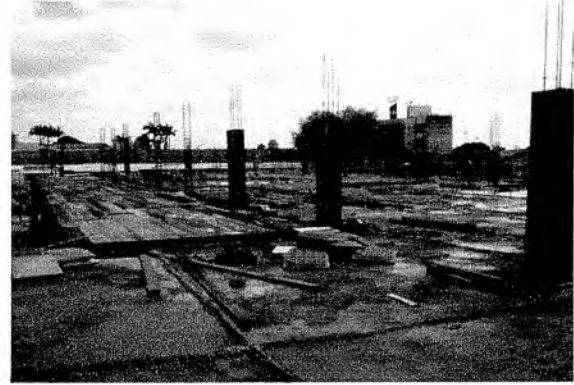
Figura 15 - Acompanhamento da obra do Hospital Regional Norte – Sobral – com área total de 55.000,00m 2
