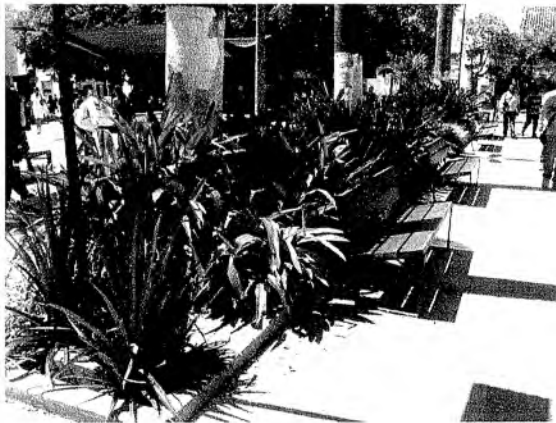
Figura 16 - Acompanhamento das obras de Requalificação das Praças do Crato
