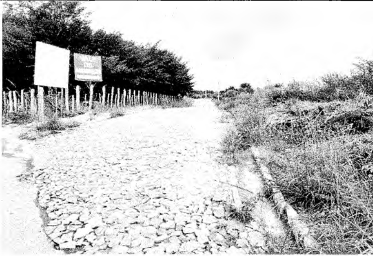
Foto 01 - Início da ESTRADA DE ACESSO DO VALE DO AMANHECER
