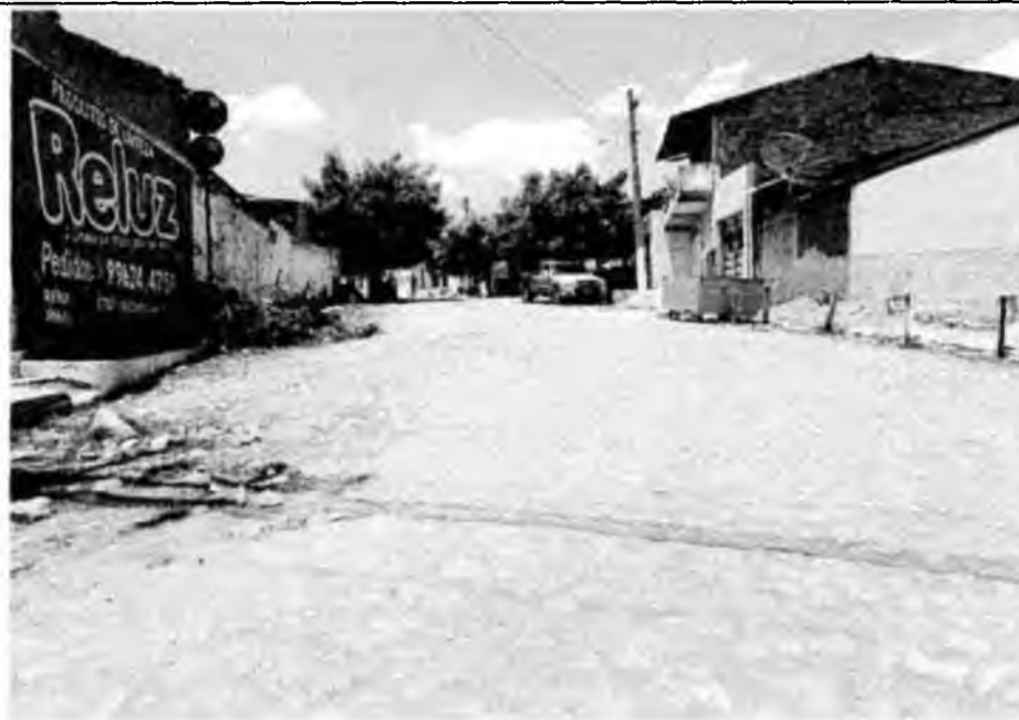
Foto 02 - Final da rua Alvaro Bomilcar
