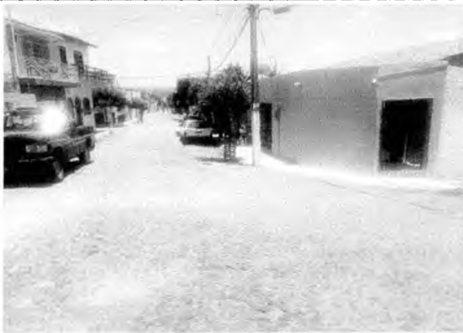
Foto 37 - Início da rua João Felipe
