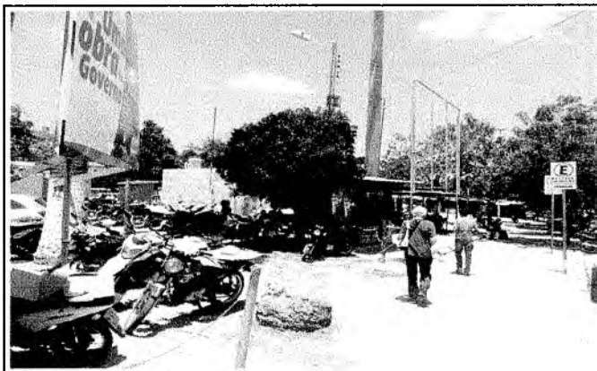
Foto: 04 Situação: ORÇAMENTO Local: PRAÇA DO PAÇO MUNICIPAL Município/UF CRATO - CE Serviço: CONSTRUÇÃO DE COBERTA METALICA Norte: Este:
