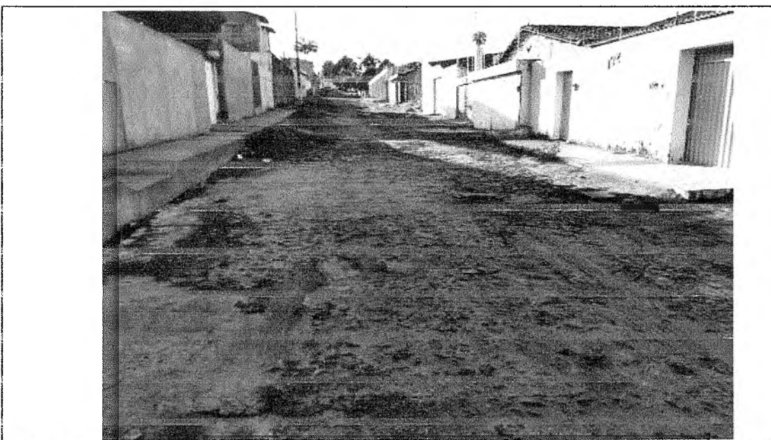
Foto 08 - Final da Rua Monsenhor Silvano de Sousa Trecho 02 Final (Coordenadas: 453475,81 E 9199435,52)
