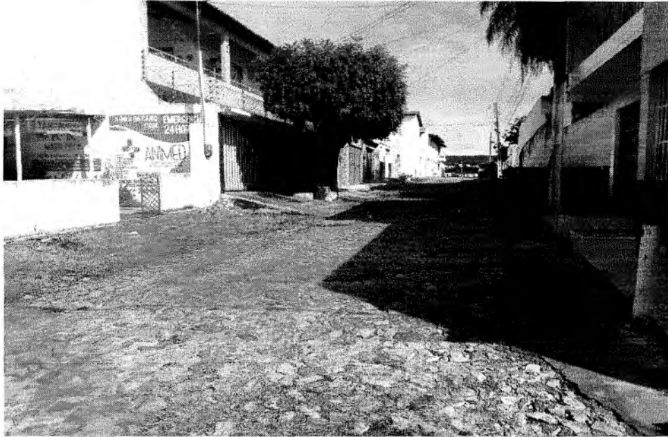
Foto 03 - Início da RUA DELMIRO GOLVEIA (Coordenadas: 453740,74 E 9199535,90 S)
