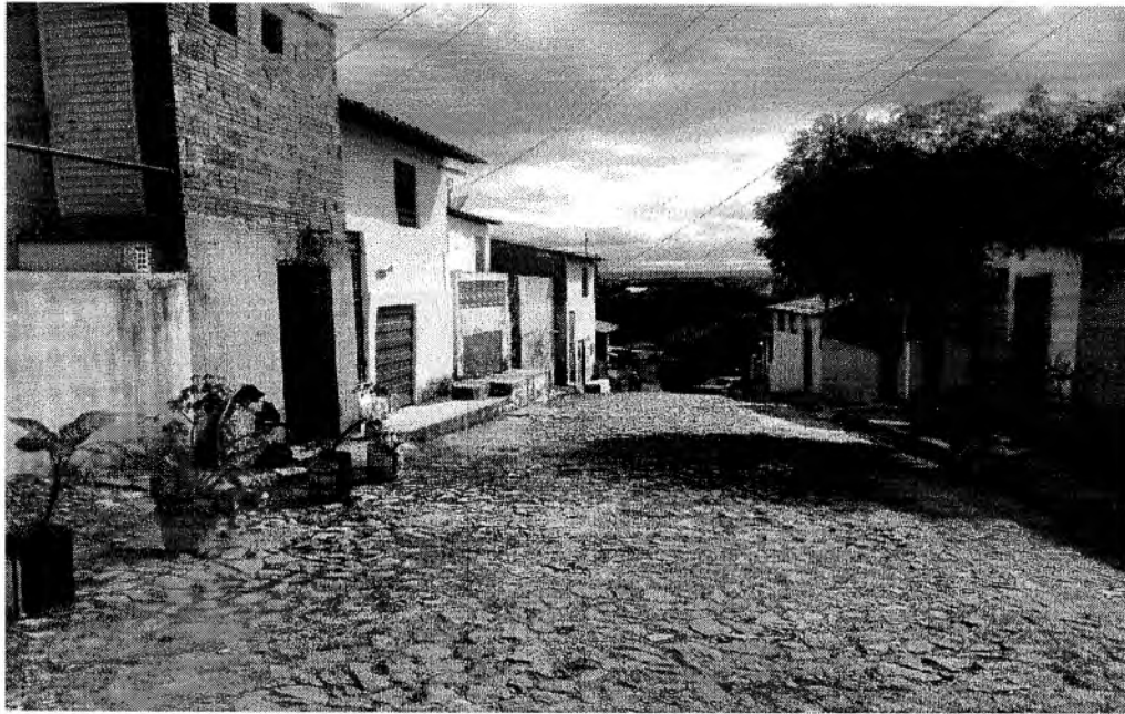
Foto 03 - Início da RUA "A" BRAZ LOPES (Coordenadas: 453766,11 E 9199,13 S)
