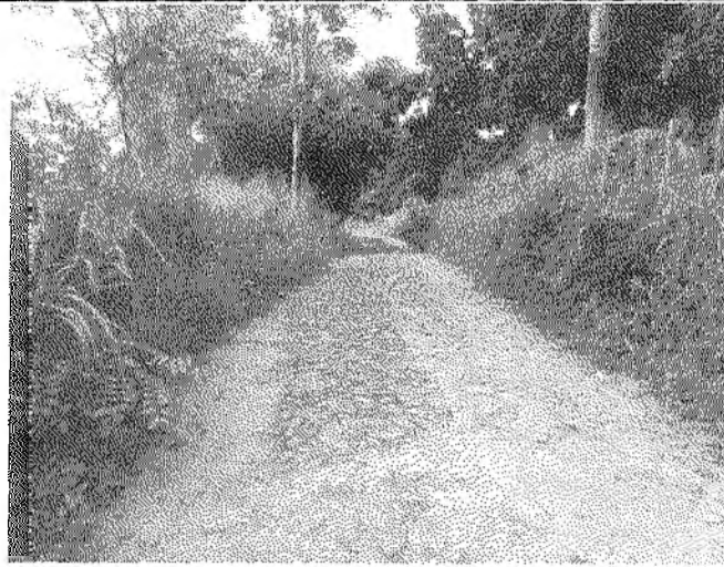
Foto 191 - Início da Rua de Acesso ao Coqueiro
